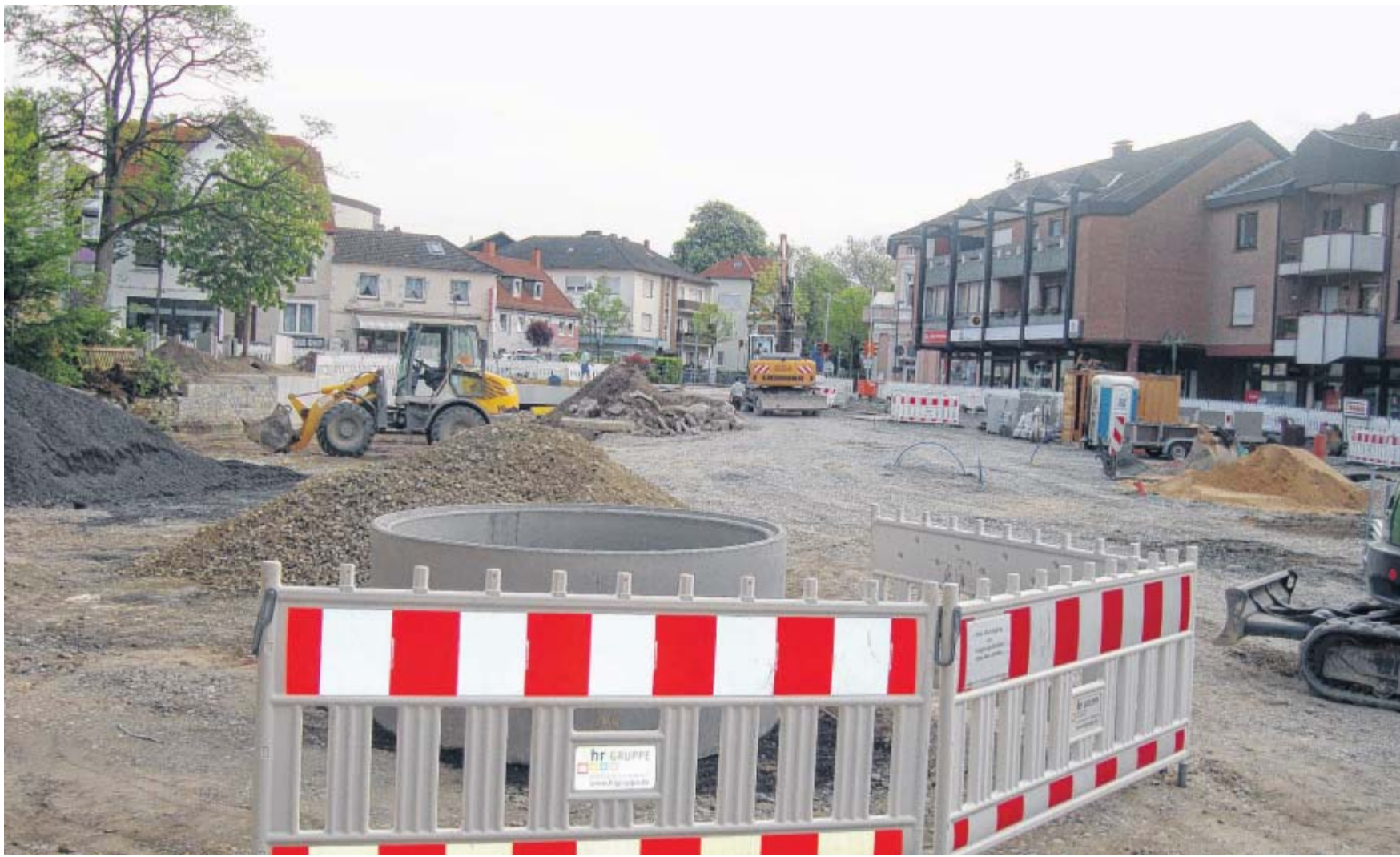
Abgesperrt: Bauzäune, Bagger, Berge voll Schotter und Sand und große Betonrohrteile dominieren auf der Baustelle am Markt. Die Schüler empfinden dadurch ihren Schulweg derzeit als sehr uneben und unsicher.
